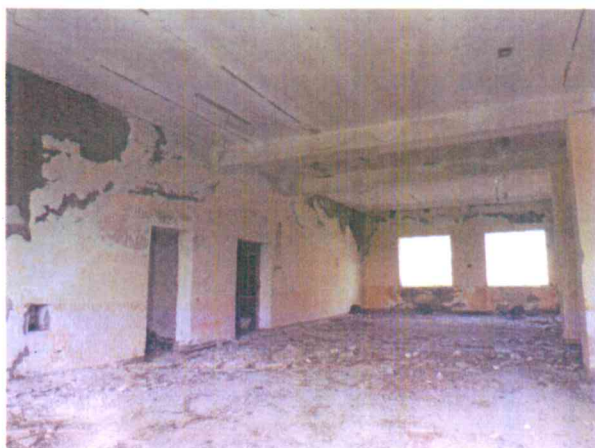
Hrsz.: 0108/1 terület, I. épületbelső
