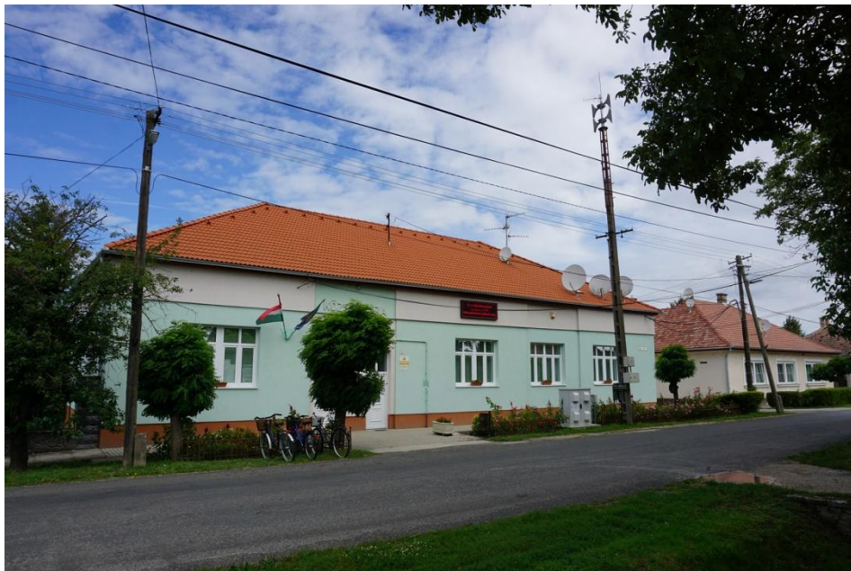
A Polgármesteri Hivatal felújított épülete az Árpád utcában
