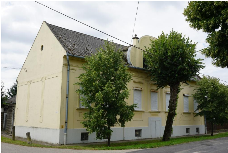
Lakóház (Bocskai utca 1.)
