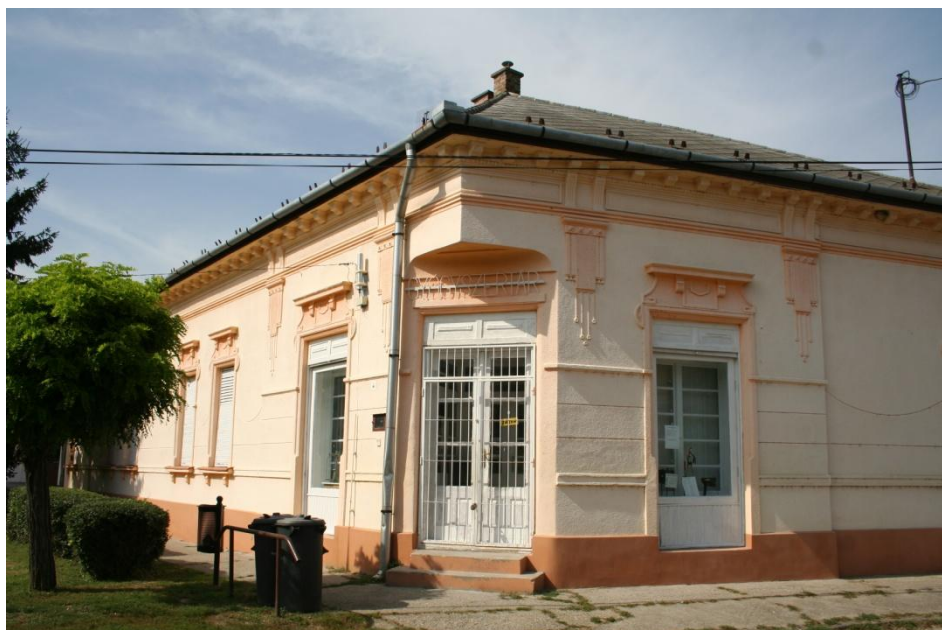
Lakóház (Hősök tere 5.)
